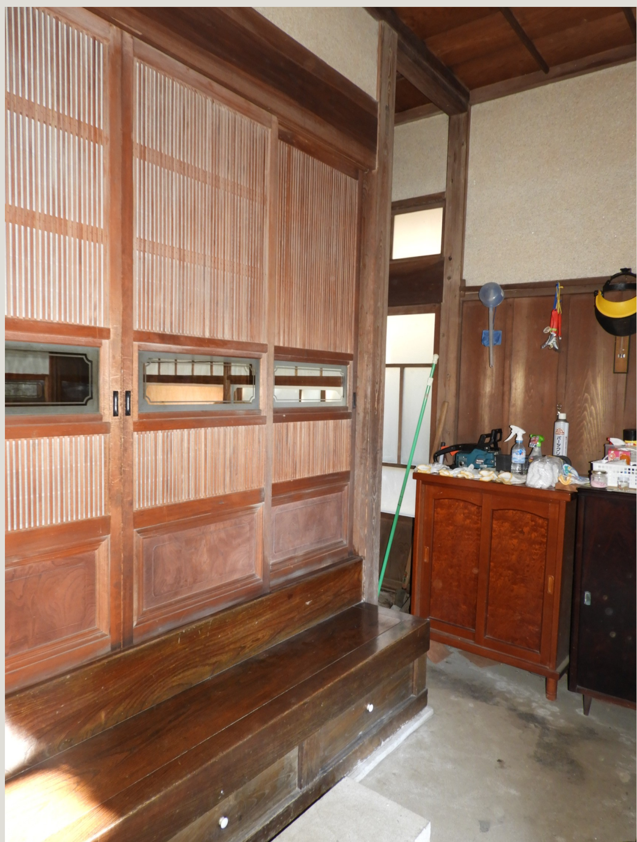
土間 正面から東面にL字型に配する廻り土間形式で、幅が半間と狭く、東面に内玄関と勝手口を設ける。
