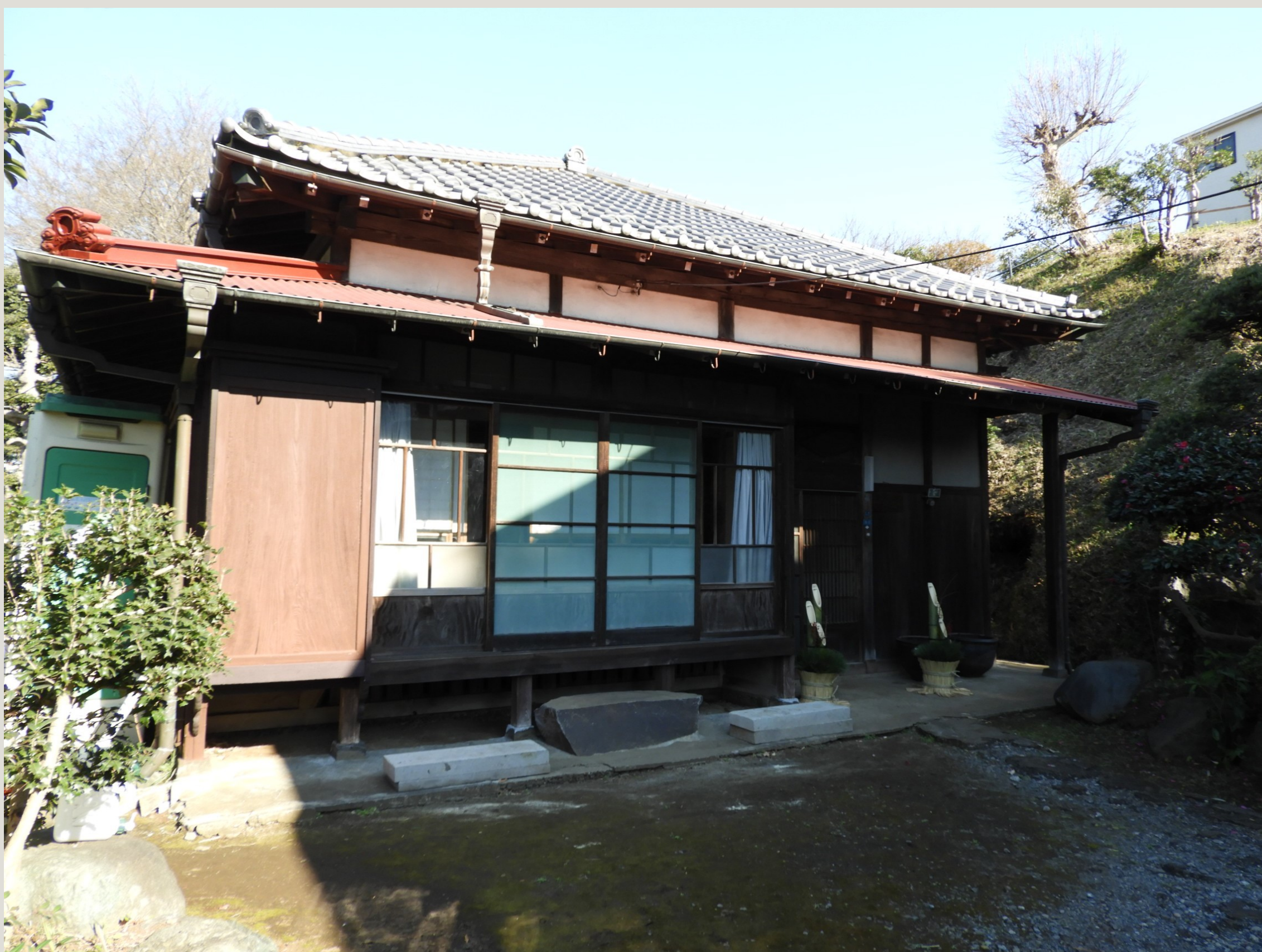
主屋 木造平屋。屋根は、寄棟造り・棧瓦葺で、四周に奥行半間の垂鉛鉄板葺の庇を巡らす。
