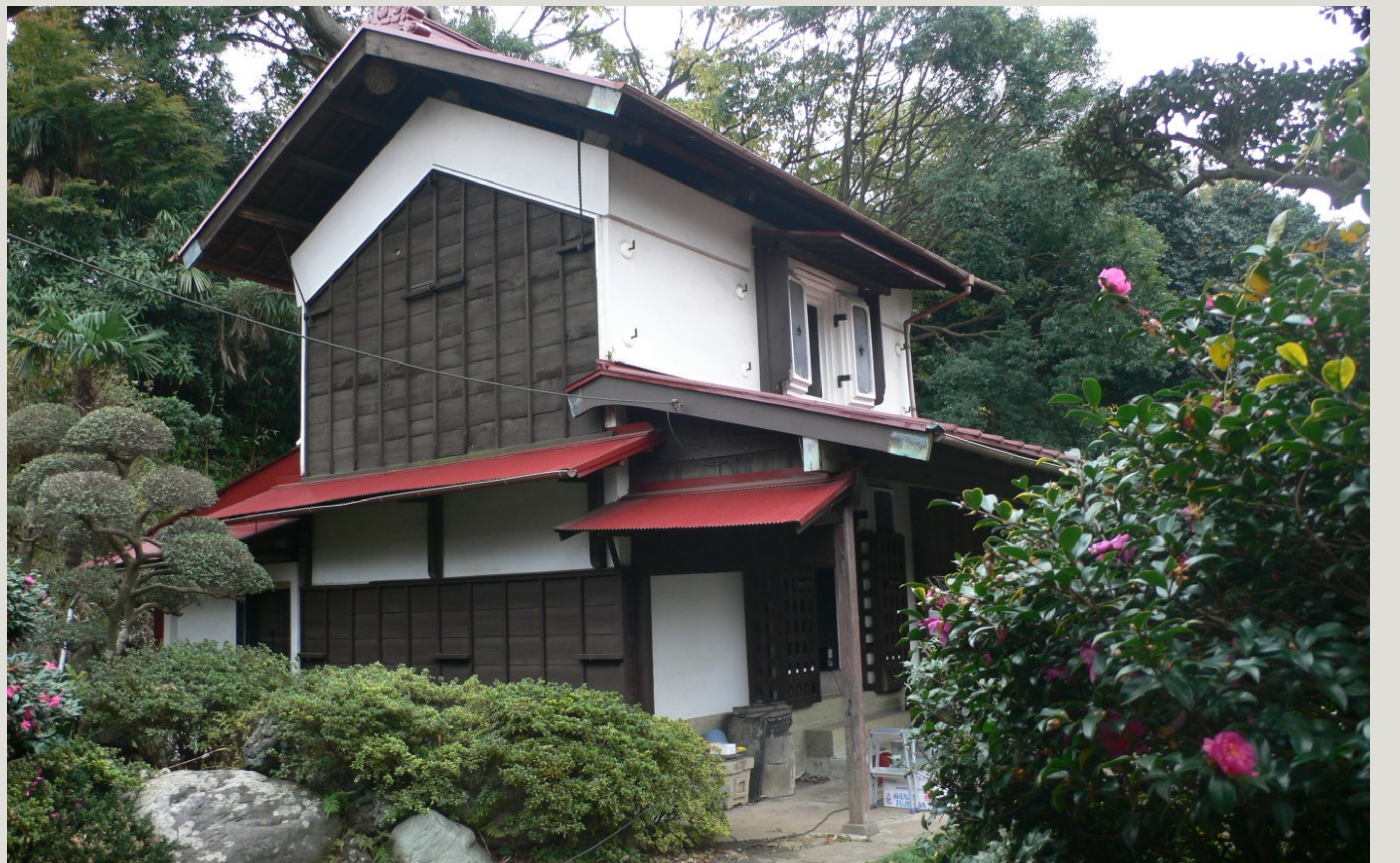
土蔵 正面に奥行1間の深い庇を設け、東側に1間半×1間半のミソグラを下屋で張り出す。
