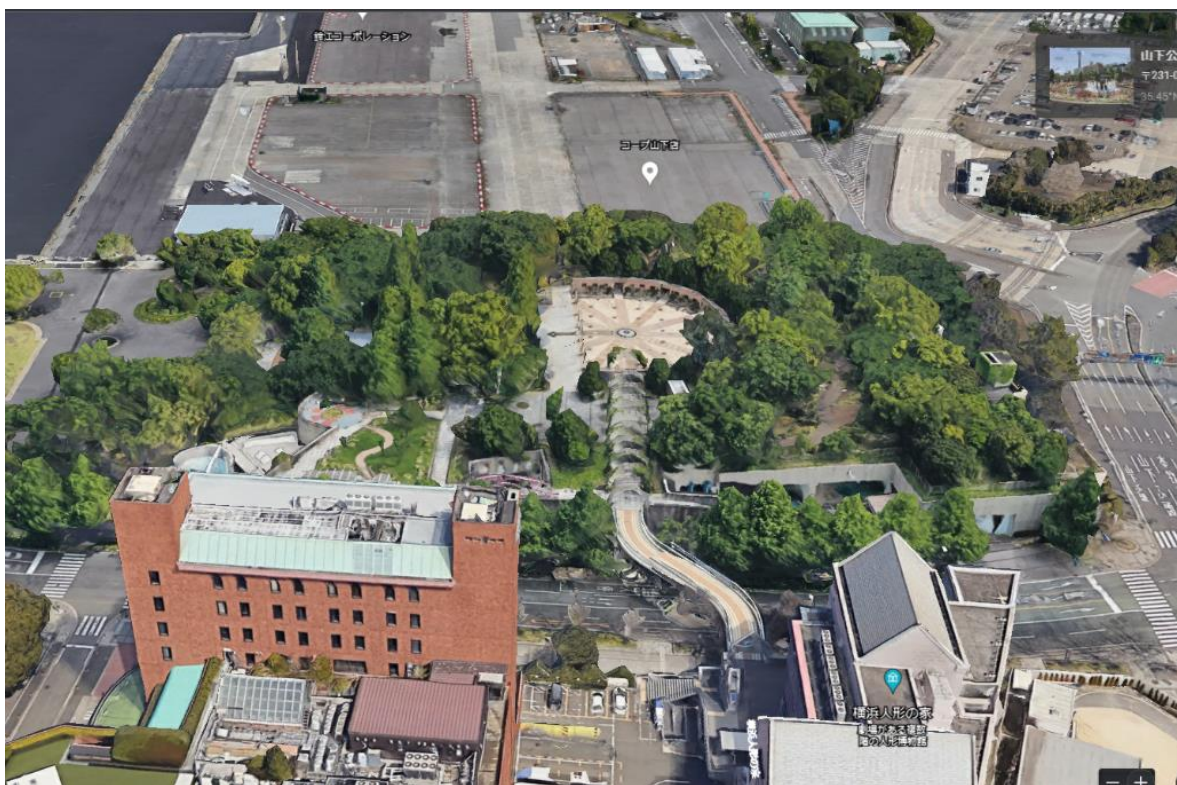
写真-2 山下ポンプ場地上部外観
