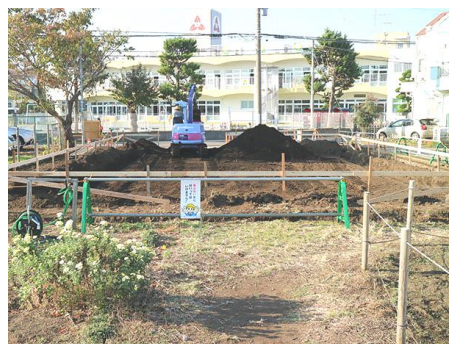
工事が始まったうさぎ児童クラブ分館
