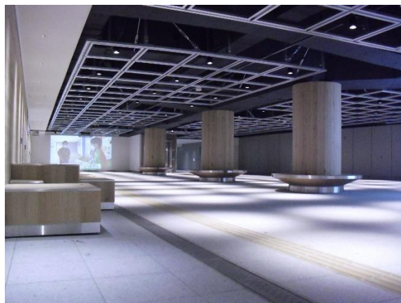
■東西地下通路(リニューアル後)
