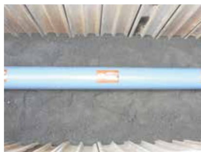
埋設された下水道管
