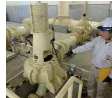
汚水ポンプ点検作業
