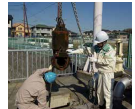
雨水ポンプの点検作業
