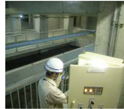
みずしより 水処理施設点検作業
