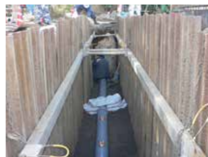
掘削土留状況
