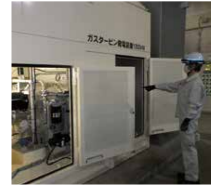
非常用発電機点検作業
