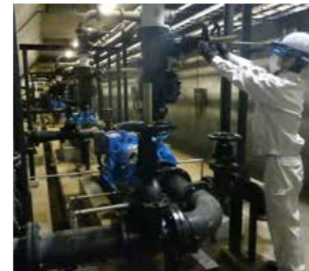
ほき 補機点検作業
