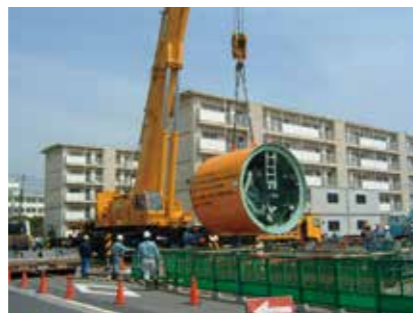
掘削機の搬入
