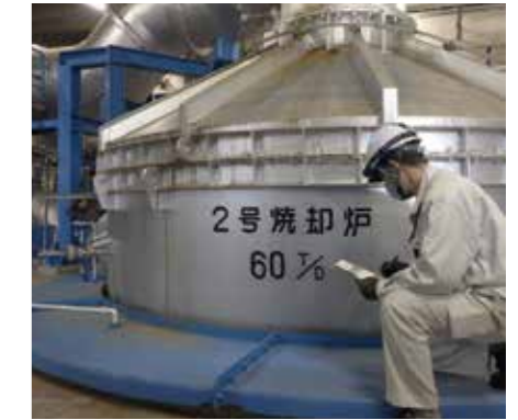
しょうきやくろ 焼却炉点検作業
