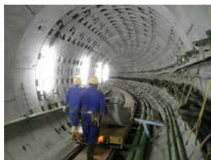
セグメントを取り付けた管内
