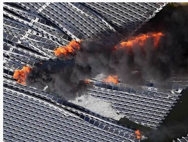
破損した箇所から火災が発生
