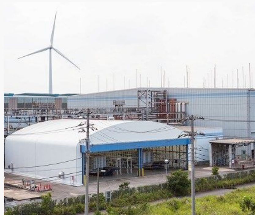
川崎リサイクルセンター外観
