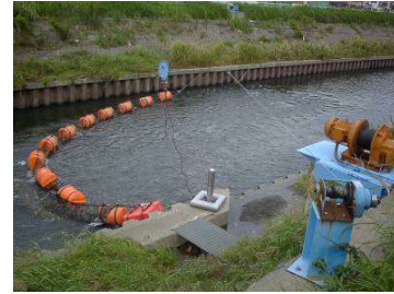
境川除じん機(大清水橋上流)
