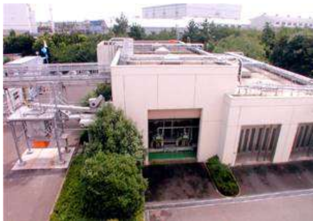
受入棟（前処理施設）
