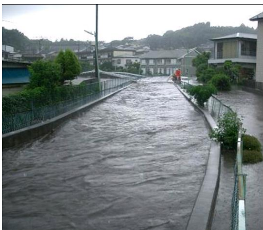
浸水状況(石切橋上流部付近)
