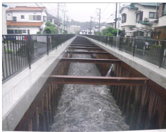
石切橋上流部付近(平成22年の台風時)
