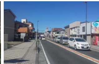
電線が地中化された国道467号
