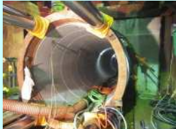
下水道葛原地区
