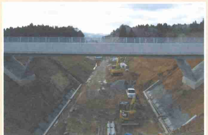
▲ 大谷海岸IC～本吉IC(仮)は今年度開通する予定 ※写真はH30年3月時点の小金沢地区 (提供：仙台河川国道事務所)
