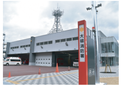
完成した大槌消防署新庁舎
