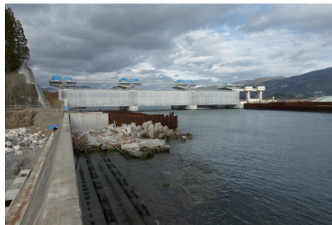
整備が進められている気仙川水門
