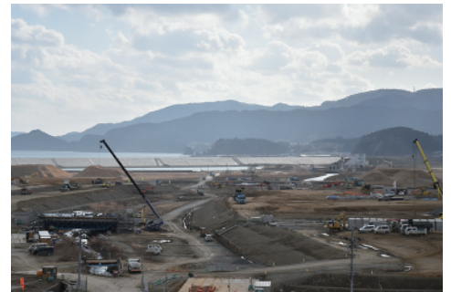
高台から見た防潮堤全景
