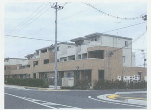
石巻市新立野第2住宅
