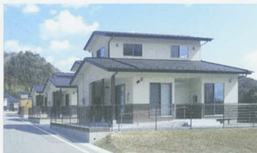
竹浦災害公営住宅(女川町)
