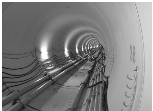
辻堂南部貯留管内部
