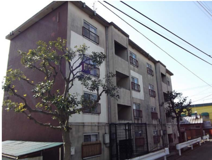
【市営古里住宅1号棟外壁現況】
