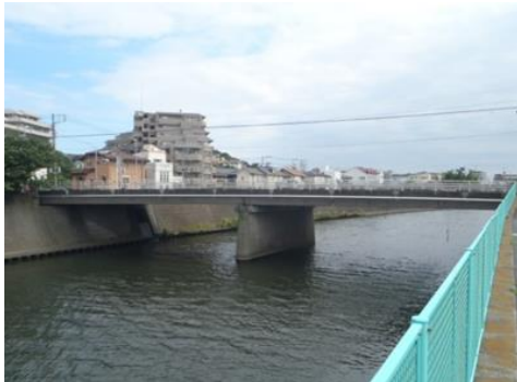
新屋敷橋【耐震化工事】
