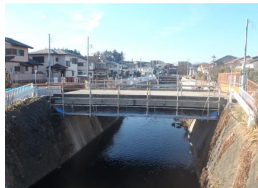
蓼中橋（下流側より）
