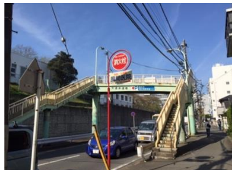
大道歩道橋【撤去工事】
