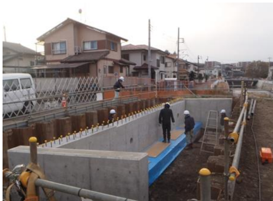
蓼中橋（新設右岸橋台）
