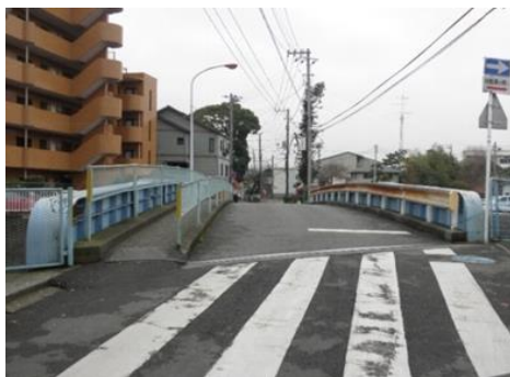
御殿橋【塗装塗り替え、高欄改修工事】
