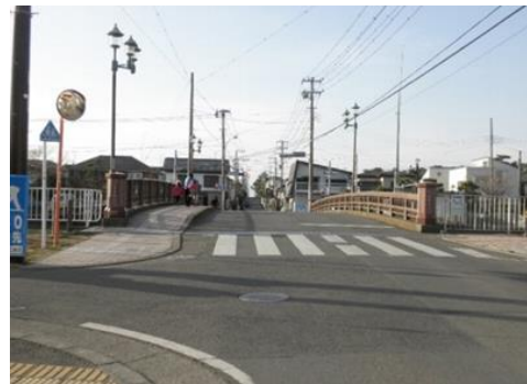
大平橋【塗装塗り替え工事】
