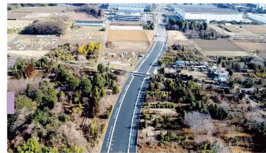
「整備中の葛原第1工区」
