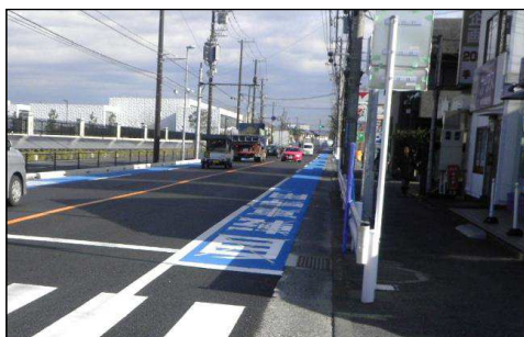
(参考写真) H27年度整備区間
