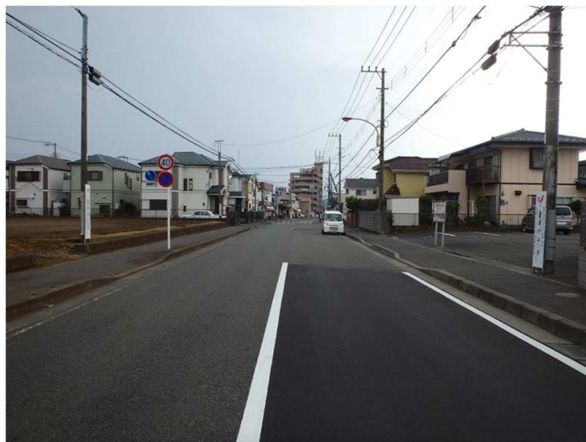
整備前状況写真
