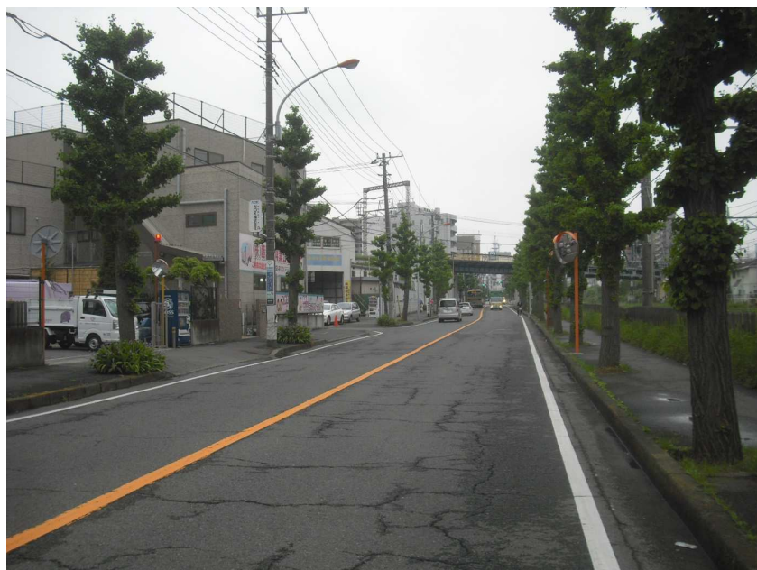
整備前状況写真
