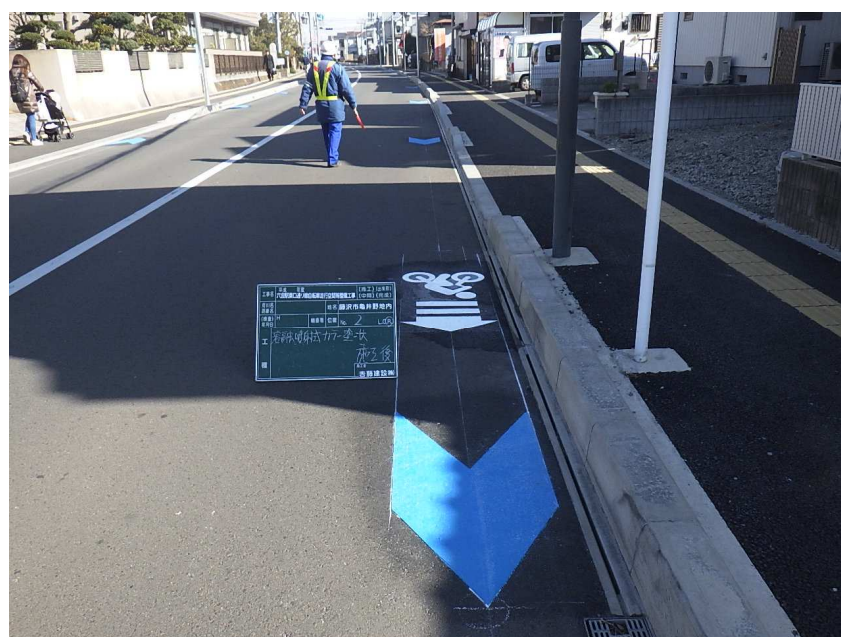
整備後状況写真
