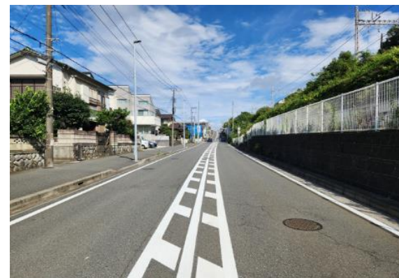
道路区画線の標示 (道路安全対策費)
